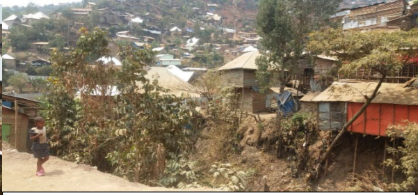
Fig.9 Latrine et douche en bâches et écoulement à ciel ouvert des eaux usées
